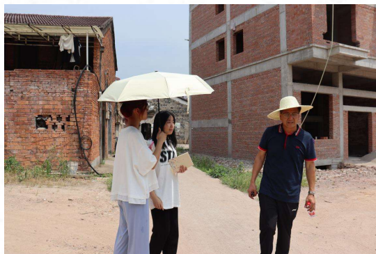
图 10 桥下东村农房改造现场
